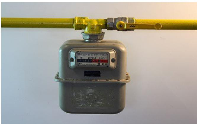
Der Kugelhahn wird geöffnet, die Gasgeräte resettet und in Betrieb genommen, auf Dichtheit überprüft und verplombt.
