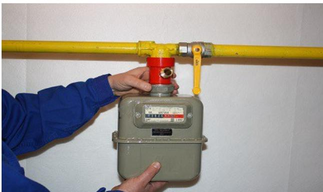
Die Verschraubung des Gaszählers wird nun am Entlüfter festgezogen.
