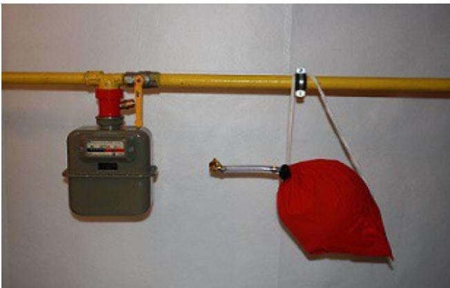
Nachdem das Abführmedium abgekoppelt ist wird der Entlüfter entnommen und der entlüftete Gaszähler montiert.
