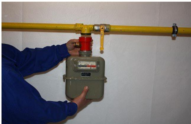
Nun werden die zuvor zusammengeführten Teile am Zähleranschlussstück angeschraubt.
