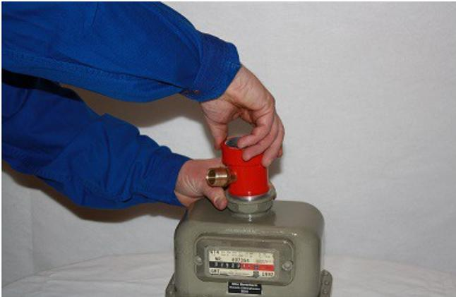
Der passende Entlüfter wird locker auf den neuen Gaszähler geschraubt.
