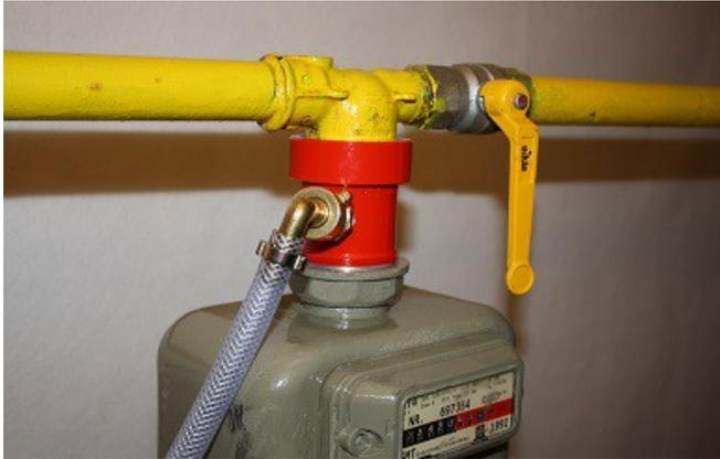
Abfuhrmöglichkeit (Blase oder Schlauch) wird direkt am Entlüfter angebracht, der Gashahn geöffnet und das Gas-Luftgemisch strömt aus dem Gaszähler durch den Entlüfter in das Abführmedium bzw. durch den Schlauch nach außen.
