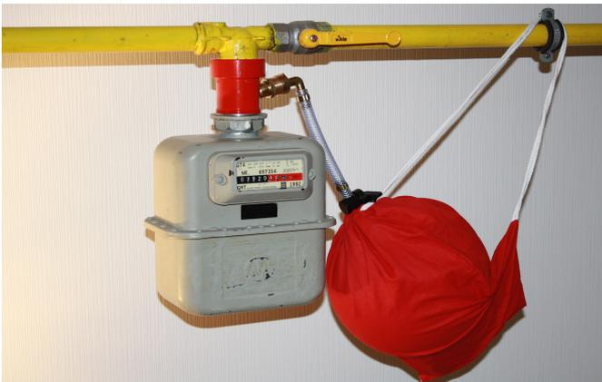
Das Gas-Luftgemisch wird in die Sammelblase abgeleitet. Ist die Blase gefüllt, wird der Hahn an der Blase verschlossen.
