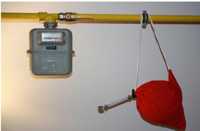
Nach dem Entlüftungsvorgang wird die Blase abgeschraubt und der Entlüfter entnommen.
