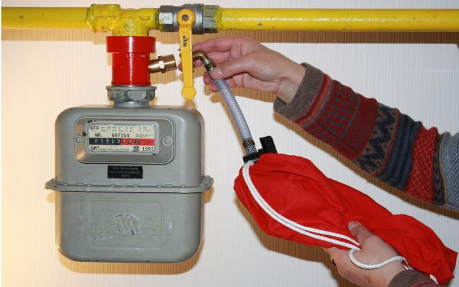
Die Sammelblase wird an den zwischen Gasleitung und Gaszähler angebrachten Entlüfter angeschraubt.
